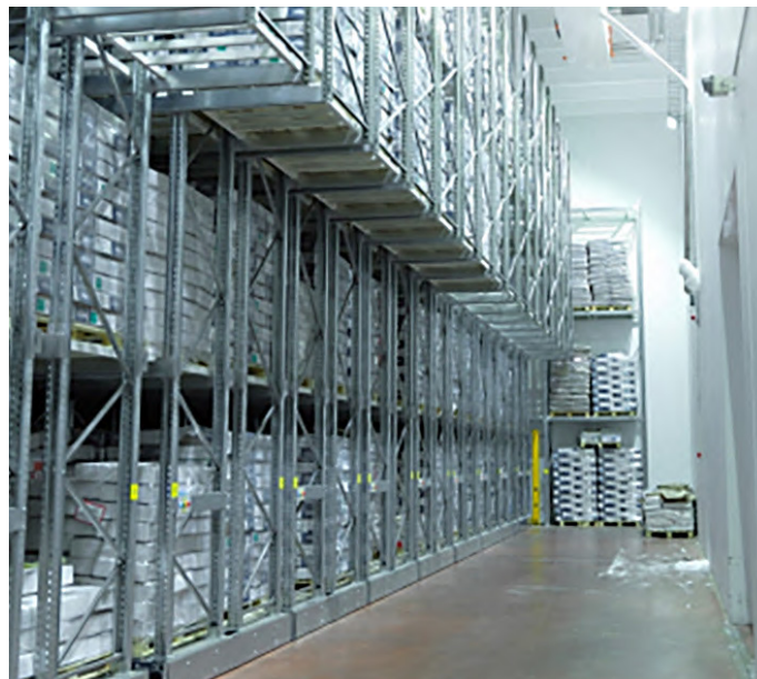
Deler av fryselageret til Brødrene Sperre A/S
